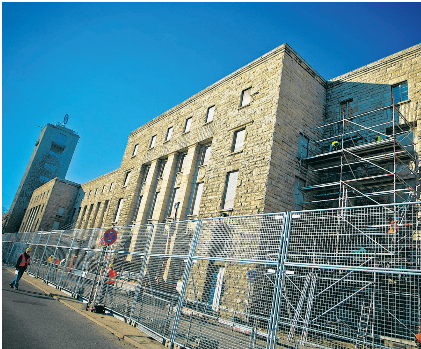
Die vorbereitenden Arbeiten für den Abriss des Bahnhof-Südflügels gehen weiter
